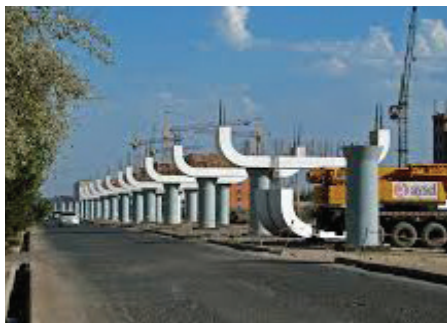
Монтаж конструкции эстакады метро
