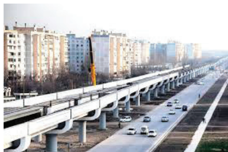
Общий вид эстакады станции метро
